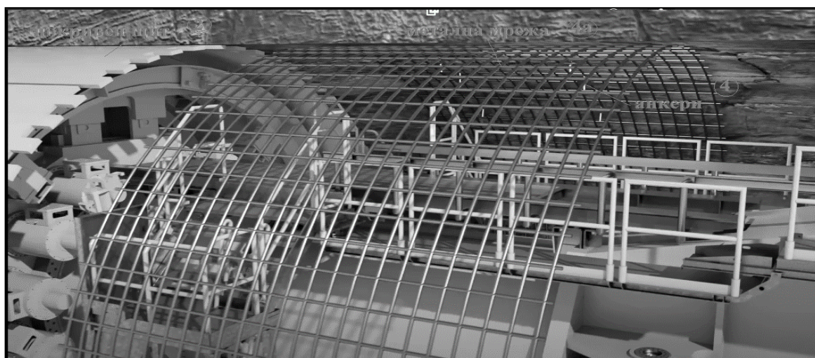
Монтаж на метална мрежа и притискане с анкерите непосредствено след покривния щит в Gripper ТПМ
